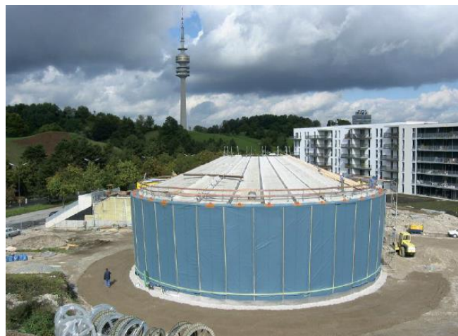
Abbildung 48: Wasserespeicher für die Nahwärmeversorgung, Speichervolumen 5 700 m 3 [FVEE 2010]
