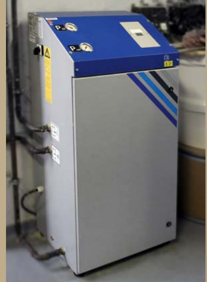
Stickstoffgenerator bei Fraunhofer UMSICHT, Foto: Silvia Lorenz
