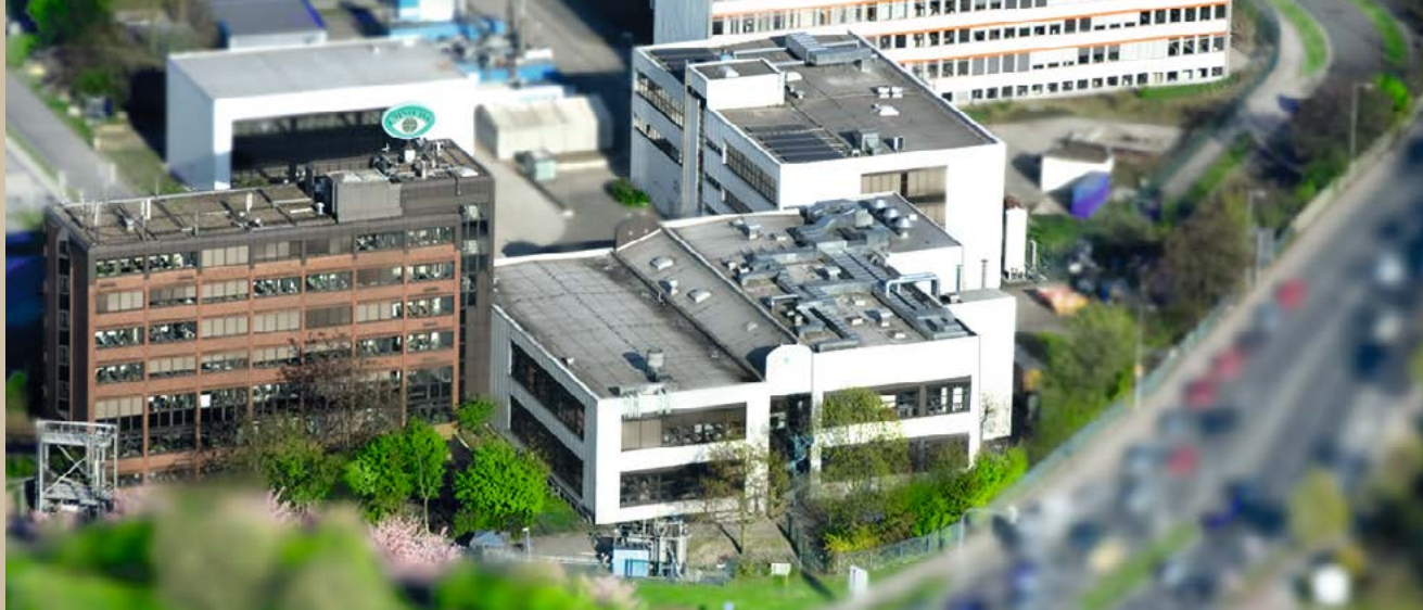
Gebäudekomplex Fraunhofer UMSICHT
